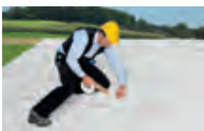
Aurutõkke paigaldamine konstruktsioonipealse soojustuse korral
