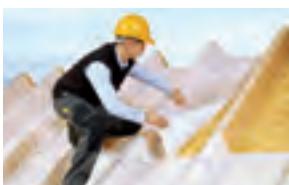
Aurutõkke paigaldamine: katuse renoveerimine väljastpoolt
