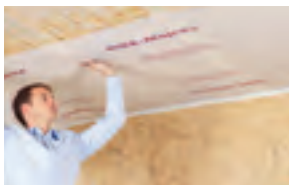
Aurutõkke paigaldamine lame-ja kaldkatustel
