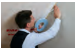
Aurutõkke ühendamine kivikonstruktsiooniga - krohvitud müüritis ja betoon
